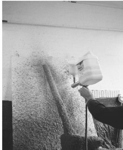
Lackierpistole läuft die Mischung aus Wasser und Bindemittel in den Lauf.
